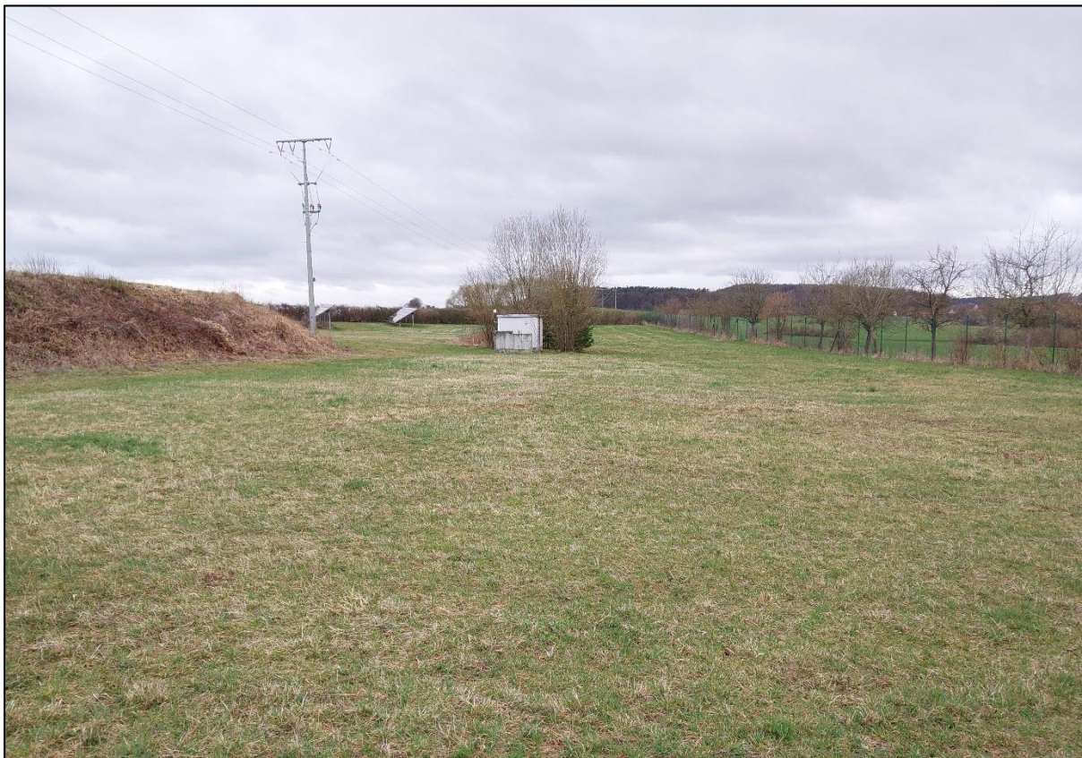
Abbildung 8: Nördlicher, nicht mit Modulen belegter Teil der Bestandsanlage. Foto: M. Bull, 31.03.2025.
