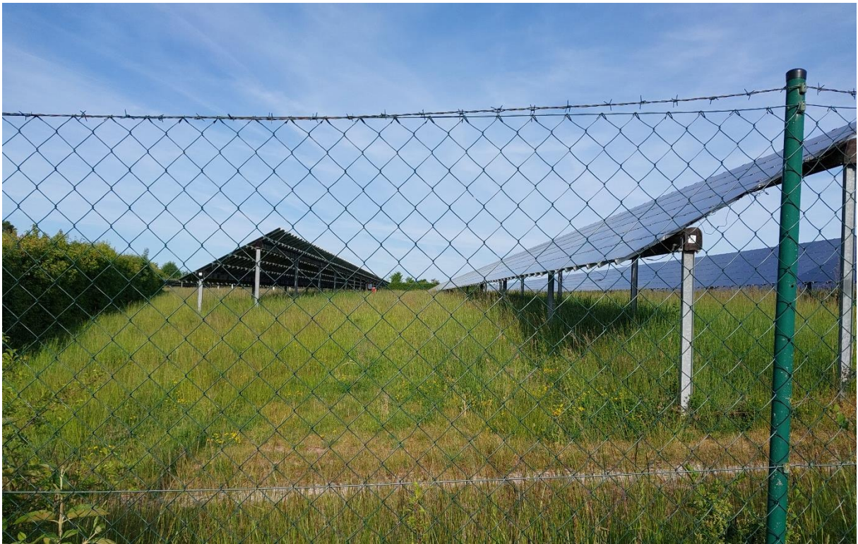
Abbildung 5: Die bestehende PV-Freiflächenanlage westlich von Kirchlauter soll ein Repowering durchlaufen und erweitert werden. Foto: M. Bull, 20.05.2025.
